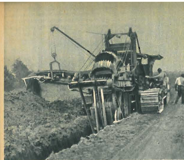
La macchina esegue uno scavo largo 30÷70 cm con 1,5 m di profondità (a cui verrà posta la tubazione); secondo i terreni, si lavorano 50÷300 m/h.
