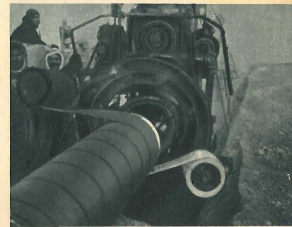
Lungo la condotta, una macchina depone sulla superficie di essa uno strato di asfalto avvolgendolo in un tessuto impregnato di sostanze isolanti.
