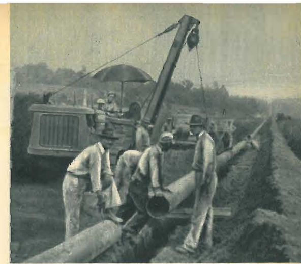
Una gru laterale su trattore, chiamata side-boom, effettua la manovra dei tubi e li cala nello scavo che viene riempito mediante un escavatore.
