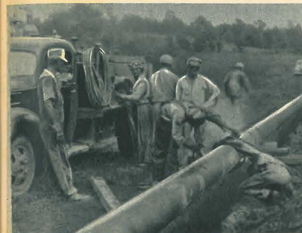
I tronchi del tubo sono saldati insieme prima di scendere nello scavo. La sezione così formata può ricevere il rivestimento isolante antiruggine.
