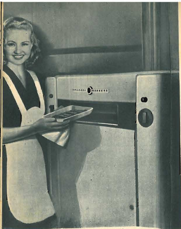
• Forno a onde centimetriche, della General Electric Co, per il trattamento degli alimenti congelati.
